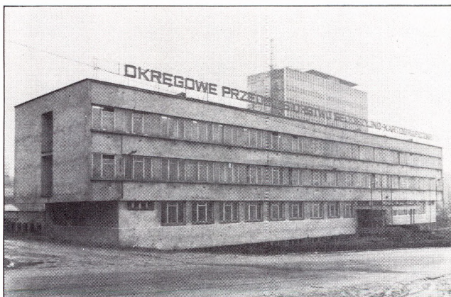
Fot. 21.5. Budynek wzniesiony w 1971 r. dla KOPM w Katowicach, ul. Damrota 25. Obecna siedziba OPGK w Katowicach
