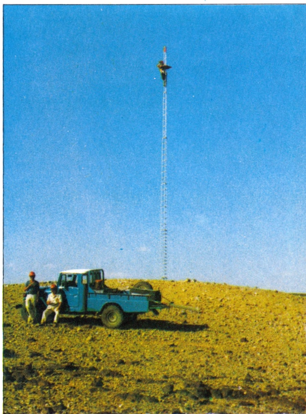
Fot. 20.5. Prace związane z zakładaniem osnowy geodezyjnej w Libii. Maszt wywiadowczy wys. 15 m ustawiony w rejonie Beni Ulid
