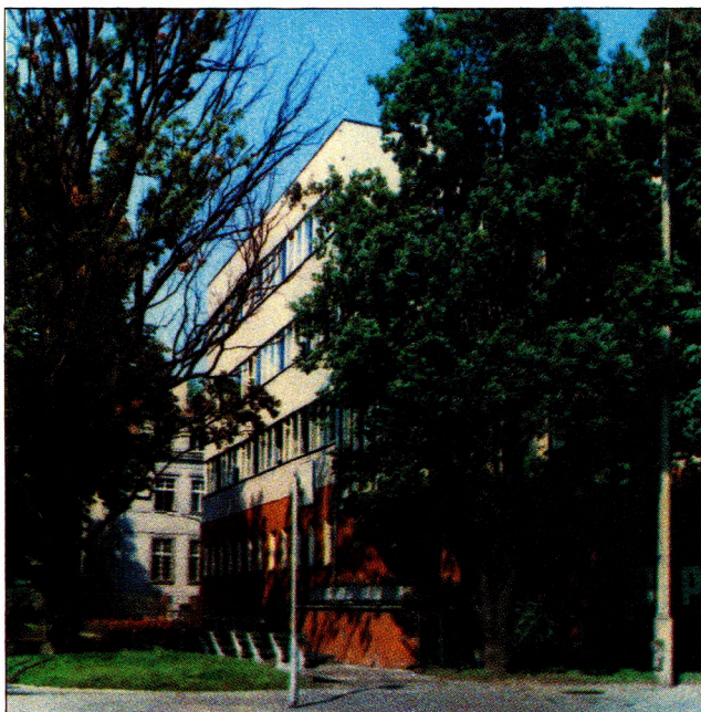
Fot. 21.6. Budynek wzniesiony w 1977 r. dla OPGK we Wrocławiu, ul. Kasztanowa 18/20
