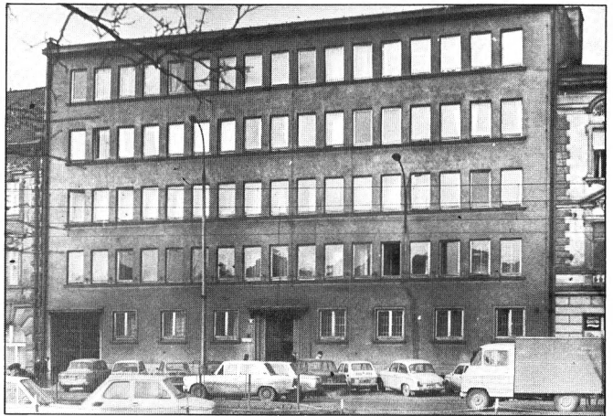
Fot. 21.2. Budynek w Krakowie, ul. Grzegórzec- ka 10 wzniesiony w 1958 r. dla KOPM w Krako- wie. Obecnie siedziba OPGK w Krakowie
