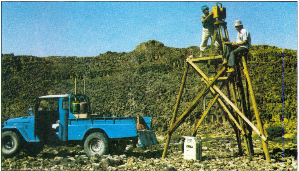
Fot. 20.4. Zakładanie osnowy geodezyjnej w rejonie Beni Ulid w Libii. Pomiary dalmierzem AGA-600 na stanowisku podwyższonym
