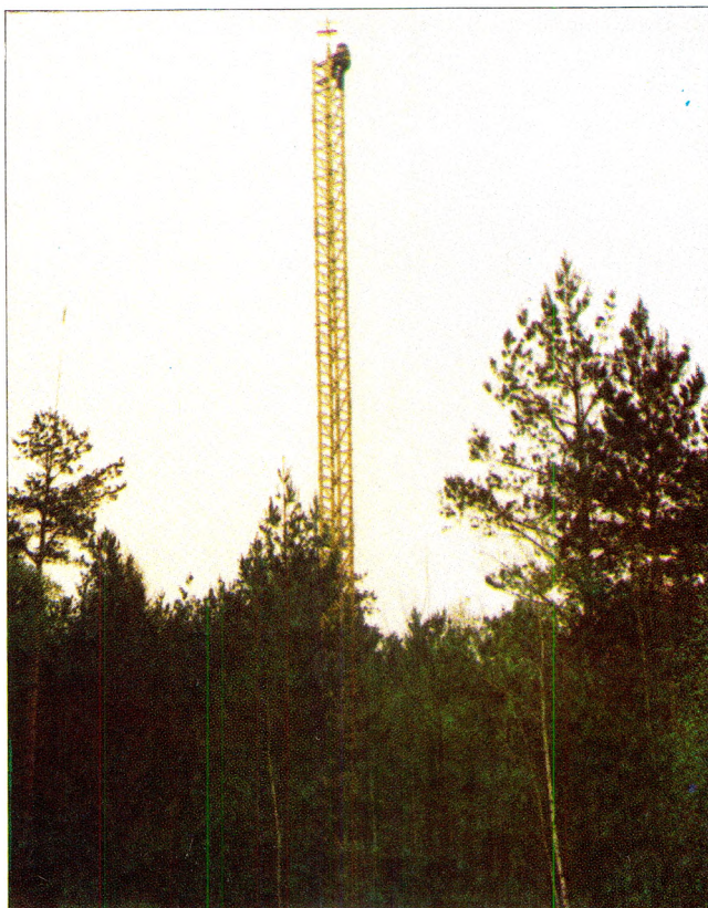
Fot. 11.4. Drabina wywiadowcza stosowana w pracach triangulacyjnych
