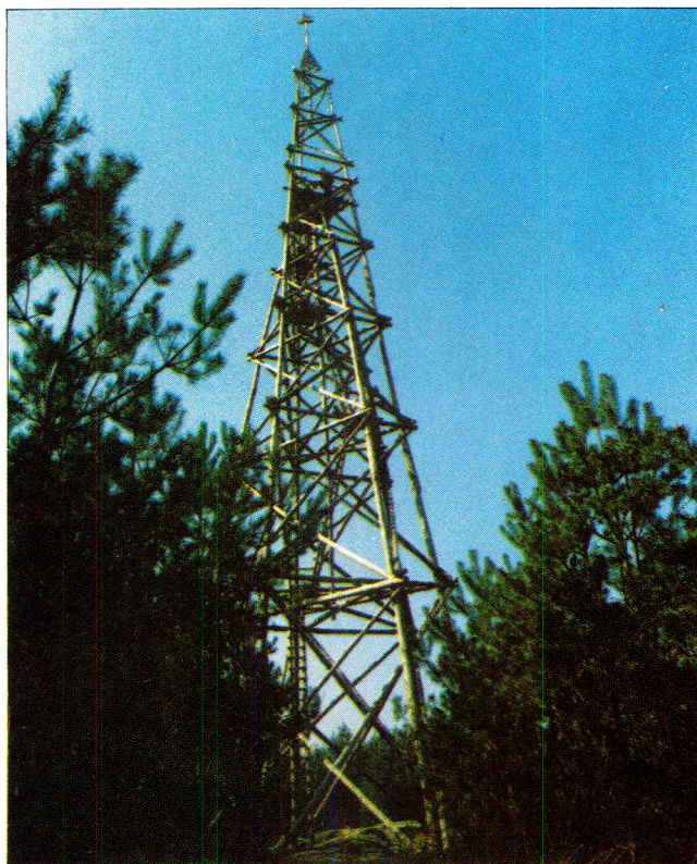
Fot. 11.5. Wieża triangulacyjna stała, trójnożna wys. 18 m
