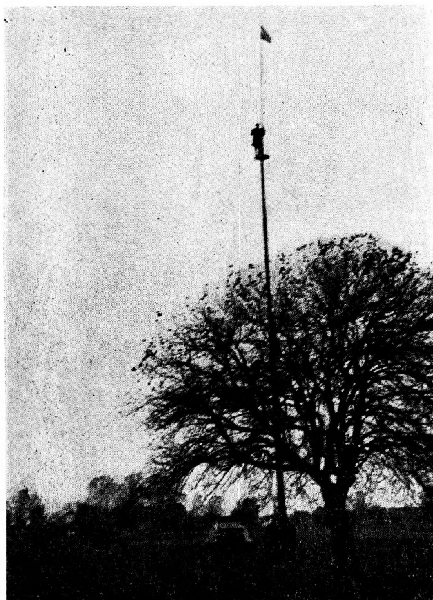
Fot. 11.1. Słup wywiadowczy wys. 18 m stosowany w pracach triangulacyjnych (sieci wypełniającej) od 1947 r.
