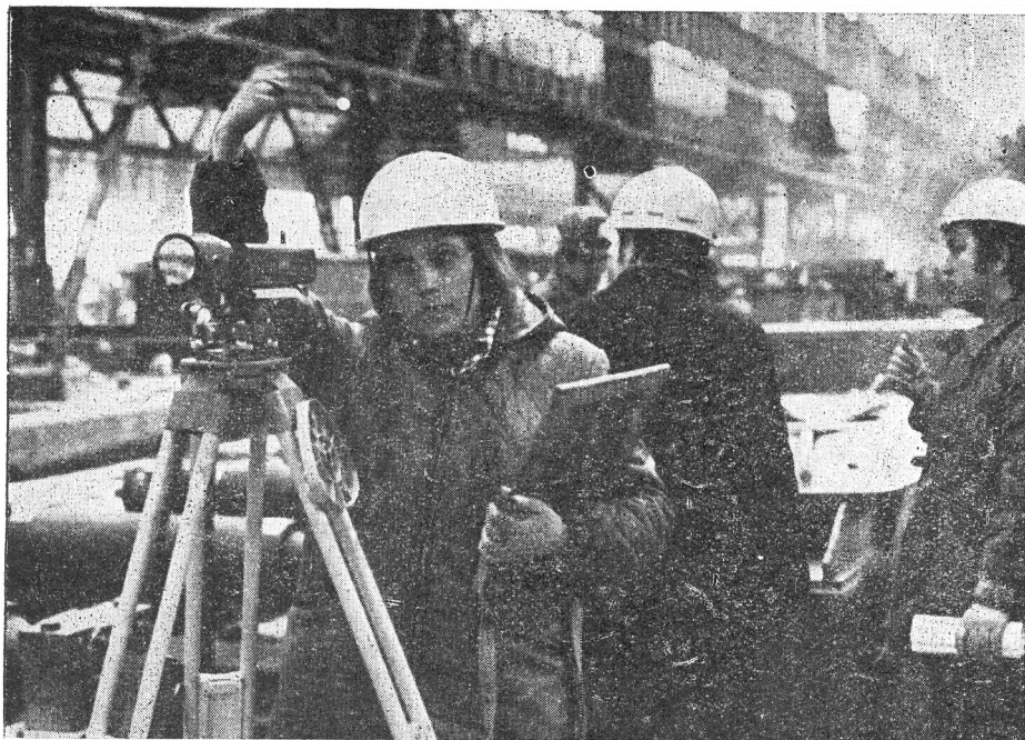
Fot. 17.3. Prace geodezyjne przy budowie walcowni dużej w Kombinacie Metalurgicznym Huta „Katowice” Fot. K. Seko
