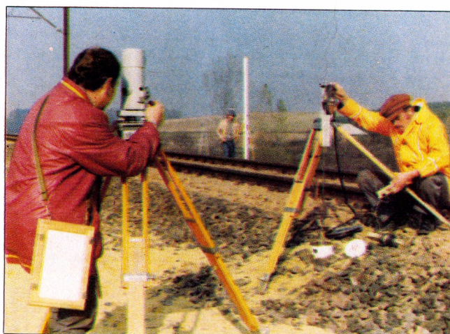
Fot. 25.3. Niwelacja na szlaku kolejowym ni- welatorem Zeiss Ni-007
