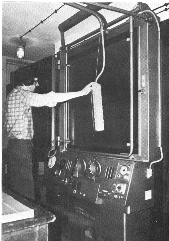
Fot. 29.2. Aparat fotoreprodukcyjny Autohorica KT-101 do przetwarzania dokumentacji kartograficznej w PPGK.
