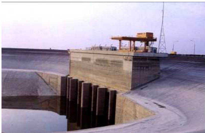
Rys. II.1.a. Górna część badanej budowli
