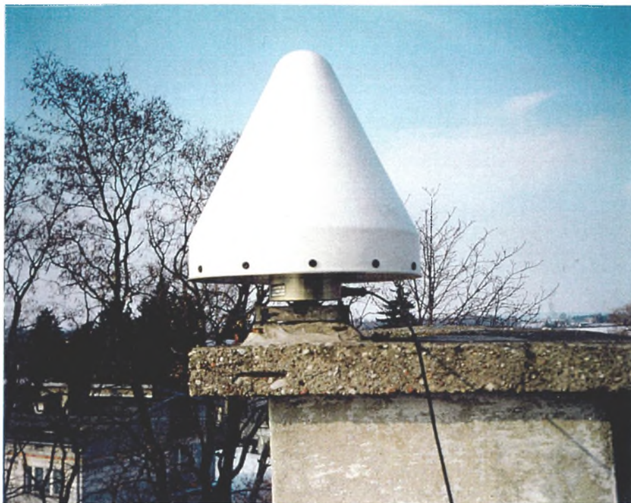
Rys. 6. Antena permanentnej stacji BOGO usytuowana na jednym z ekscentrów punktu EUREF nr 0217
