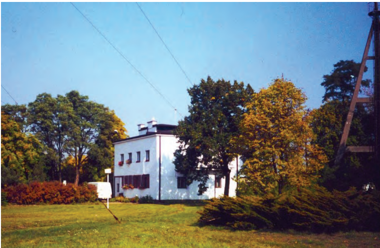
Rys. 6. Budynek główny Obserwatorium z widoczną anteną stacji BOGO na dachu budynku, wieżą betonową oraz budką meteorologiczną z czujnikami do automatycznej rejestracji danych meteo
