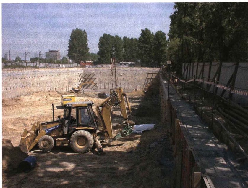
Rys. 3 Fragment wykopu pod 4-kondygnacyjny garaż podziemny
