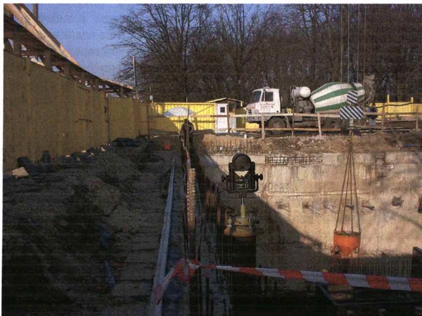
Rys. 2 Stanowisko zintegrowanego tachimetru elektronicznego TC 2002 i stanowisko reflektora
