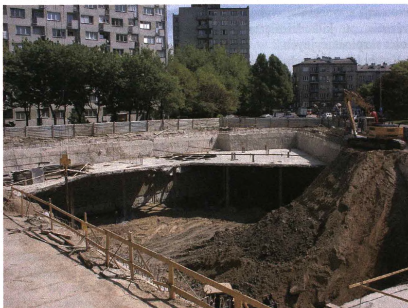
Rys. 4 Widok ogólny prac ziemnych i budowlanych
